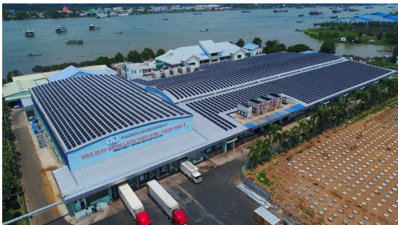
Hệ thống điện mặt trời của Nhà máy đông lạnh thủy sản số 1 do Tập đoàn Sao Mai lắp đặt
