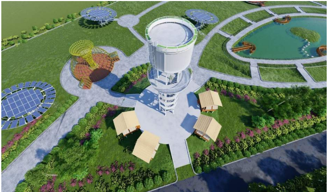
Phối cảnh đài nước trong Khu du lịch Điện mặt trời An Hào
