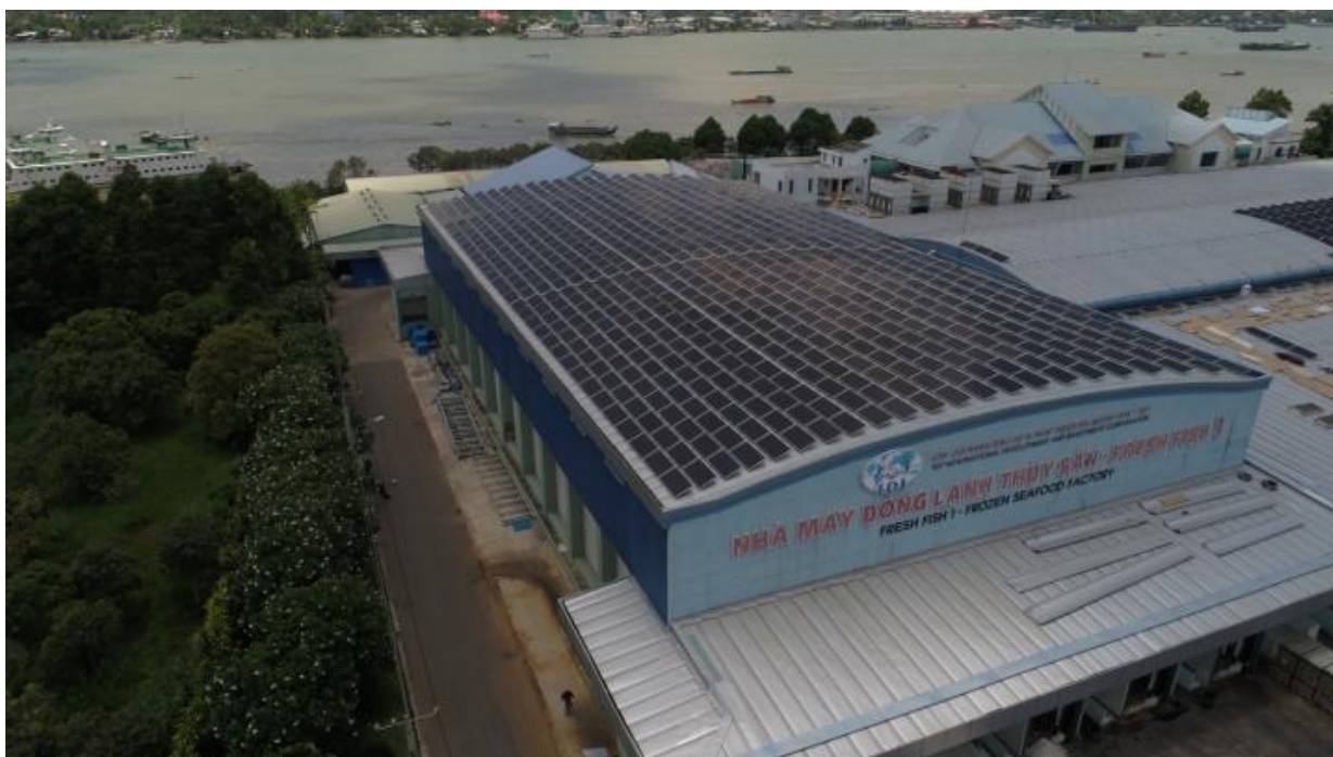
Những tấm pin năng lượng mặt trời đã được lắp đặt tại Nhà máy đông lạnh thủy sản IDI
